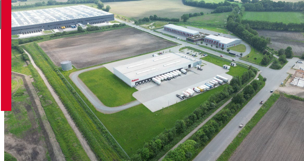
Gewerbegebiet Rendsburg Port Süd: Mit Fitshop und Raben-Logistik sind bereits namhafte Unternehmen angesiedelt. Stand Frühjahr 2026 stehen im schwerlasttauglichen Gewerbegebiet noch rund 160.000 m 2 für weitere Ansiedlungen zur Verfügung.
